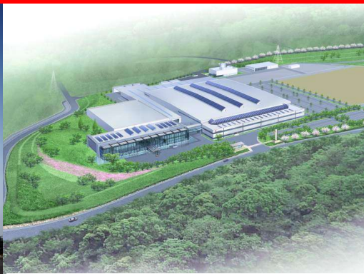
Nouvelle usine de production au Japon Toki
